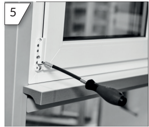
5 Einstellung des Anpressdrucks über das Ecklager. (SW4)
