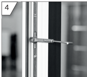
Einstellen des Anpressdrucks über einzelne Schließzapfen mit Ring-/Gabelschlüssel (SW11)
