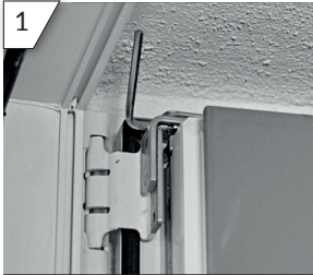
1 Seiteneinstellung des Fensters über die Schere. (SW 4)
