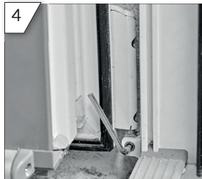
4 Seiteneinstellung des Fensters über das Ecklager. (SW 4)
