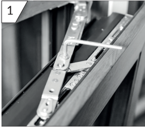
Seiteneinstellung des Fensters über die Schere. (SW4)
