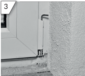
3 Höheneinstellung des Fensters über das Ecklager. (SW 4)
