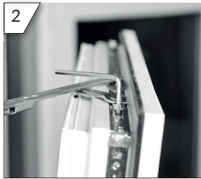
2 Einstellung des Anpressdrucks über die Schere. (SW 11)
