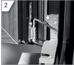
Einstellung des Anpressdrucks über die Schere. (SW 4)
