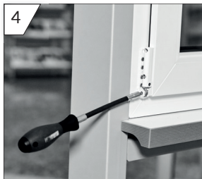
4 Seiteneinstellung des Fensters über das Ecklager. (SW4)
