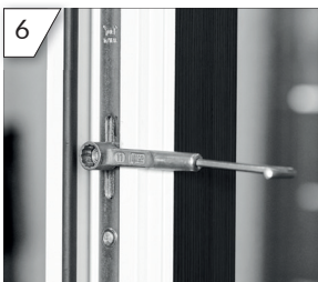
6 Einstellen des Anpressdrucks über einzelne Schließzapfen mit Ring/Gabelschlüssel (SW11)
