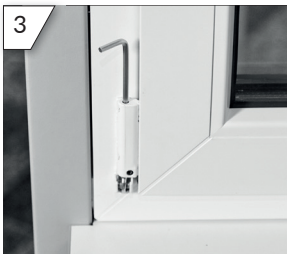
3 Höheneinstellung des Fensters über das Ecklager. (SW4)
