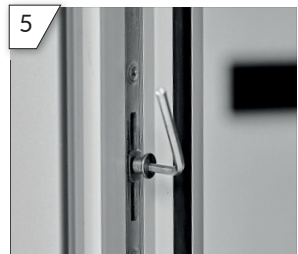
5 Einstellen des Anpressdrucks über einzelne Schließzapfen. (SW 4)
