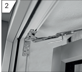
2 Einstellung des Anpressdrucks über die Schere. (SW 4)
