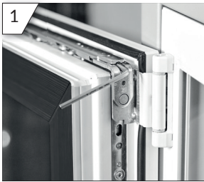
1 Seiteneinstellung des Fensters über die Schere. (SW4)
