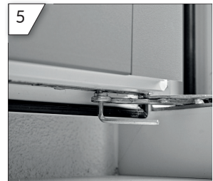
5 Einstellung des Anpressdrucks über das Ecklager. (SW 4)
