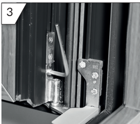
Höheneinstellung des Fensters über das Ecklager. (SW4)
