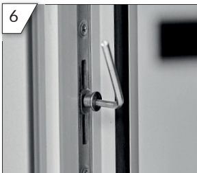
6 Einstellen des Anpressdrucks über einzelne Schließzapfen. (SW 4)
