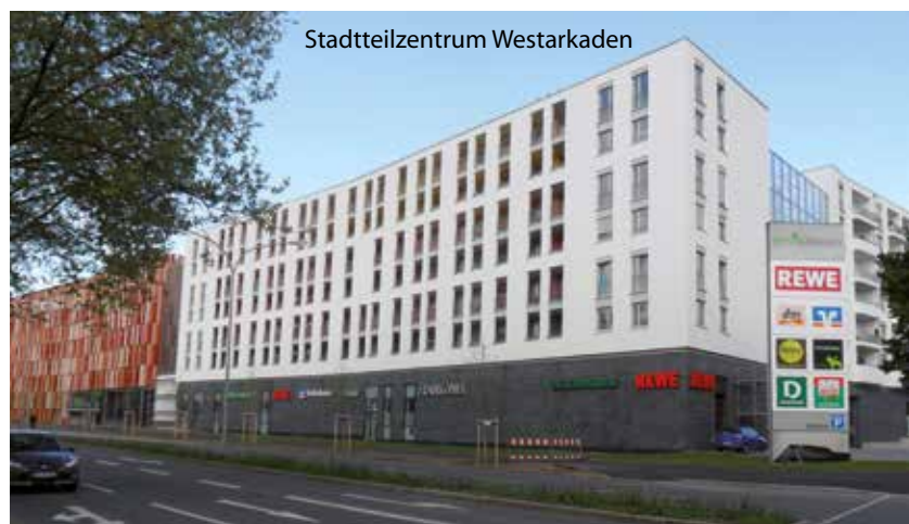
Eingebaut wurde das Fenstersystem hilzinger Creativ mit 3-fach-Verglasung
