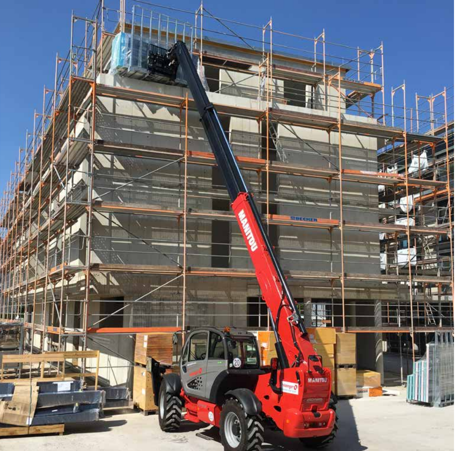
Sichere und arbeits erleichternde Anlieferung der Fenster auch im Obergeschoss mit dem Teleskopstapler.
