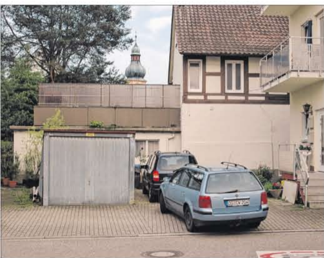
Die Stahlgarage in der Hauptstraße 15 soll abgebrochen und dafür direkt am Gebäude eine Einzelgarage errichtet werden. Das soll für mehr Parkplätze sorgen. Foto: Günter Ferber
