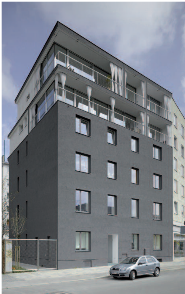
Das 1904 errichtete Gebäude wurde komplett saniert und um zwei Stockwerke ergänzt. In den oberen Stockwerken sind die Schienen für die Sonnenschutzgardinen das Fassadensystem integriert.
