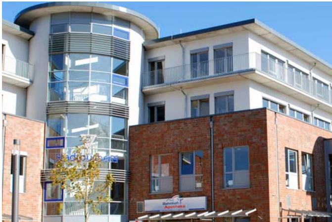
Im "Forum am Bahnhof" in Quickborn hat Aldra unter anderem 250 Fenster eingesetzt.
