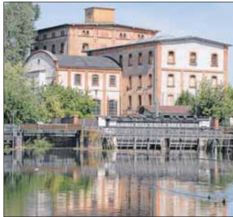
Die Turbinenhalle (links) bleibt bestehen und wird in das neue Verwaltungszentrum integriert. Foto: Hans-Jürgen Walter
