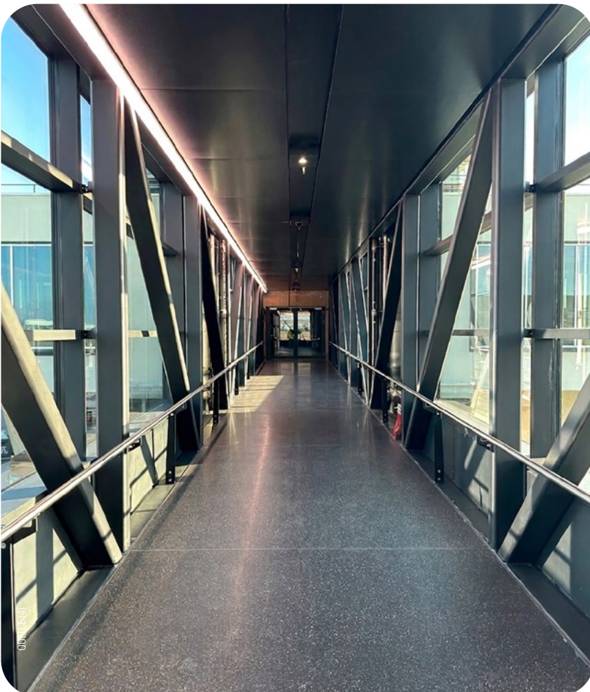
Die Verbindungsstege zu den Fluggastbrücken erhielten Pfosten-Riegel-Fassaden mit transparenten Ausführungen.
