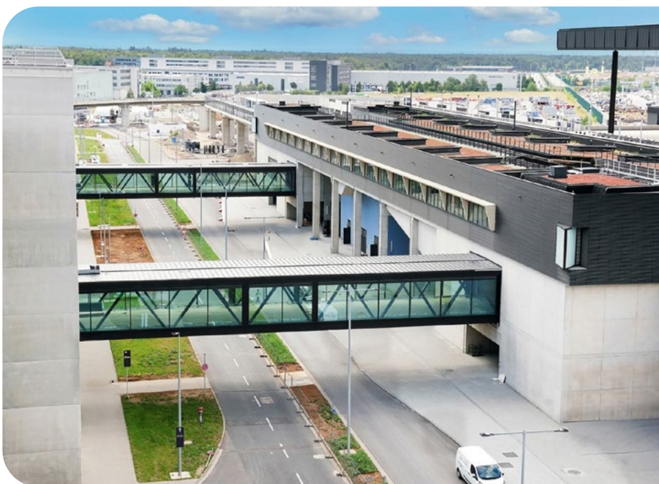
Beim neuen Personen-Transport-System wurden u. a. Aluminium- und Stahl-Pfosten-Riegel-Fassaden von Hilzinger verbaut.
