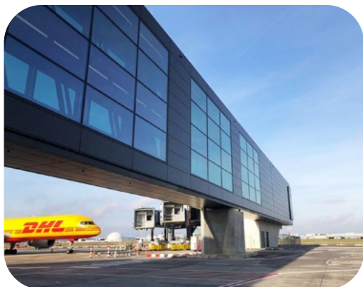
Beim Flugsteig J kamen transparente Fassaden von Hilzinger mit absturzsichernden Verglasungen zum Einsatz.
